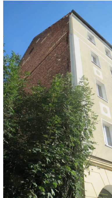
Giebel links (vor der Sanierung)
